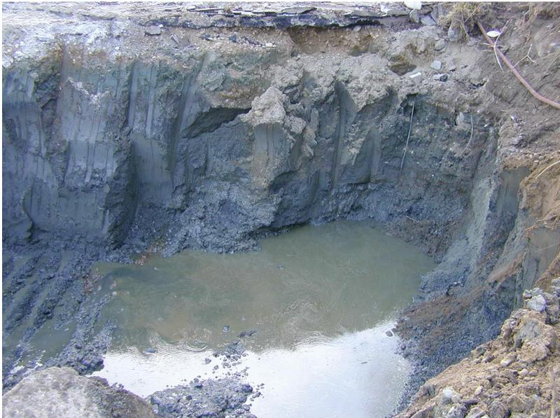
La presenza di una falda superficiale, prossima al piano campagna, limita l'utilizzo di un escavatore, impedendo una visione dei terreni sotto falda e portando ad un rimescolamento del materiale con l'acqua che non consente di prelevare campioni rappresentativi della zona satura.
