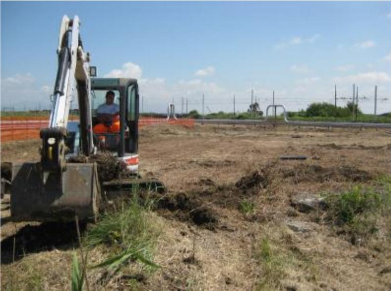
Inoltre l'utilizzo di un escavatore è più invasivo e la qualità dei campioni di terreno è generalmente inferiore. Di contro vi è la possibilità di osservare le pareti ed il fondo dello scavo ed avere una migliore visione d'insieme, rispetto a quella data da una carota di alcuni cm di diametro.
