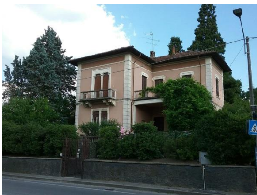
Vista frontale della villa
