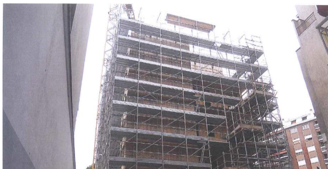
Fabbricato in via Maiocchi
